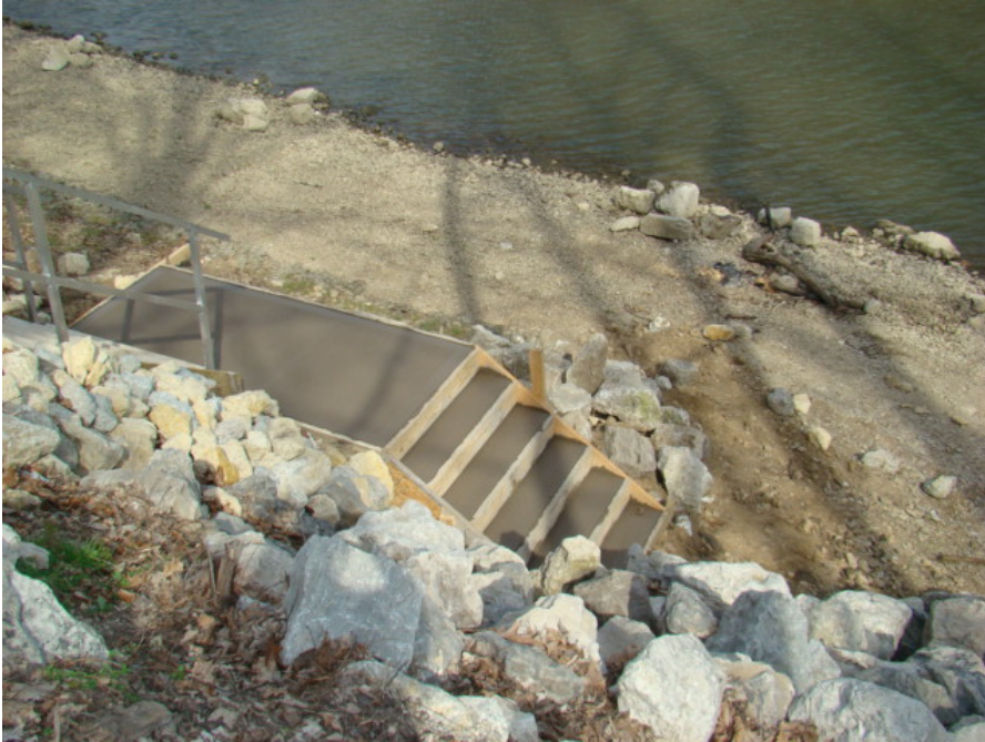
Second section of Access #1, the last concrete pour
